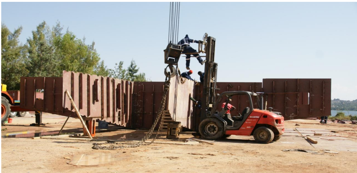
Shughuli za ujenzi wa kivuko kipya cha Busisi zikiwa zinaendelea.
